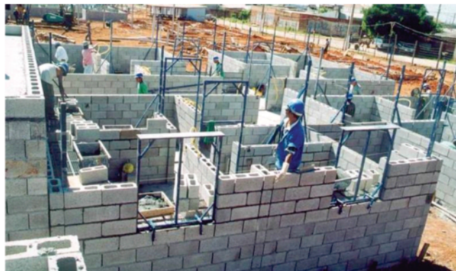
Fixação de batentes e contramarcos
