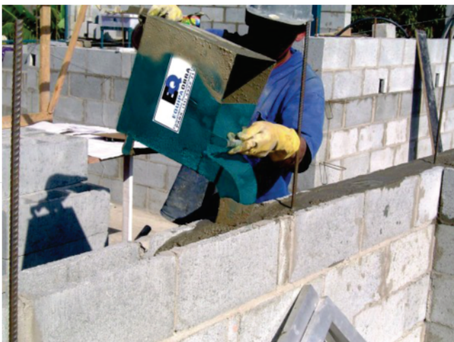
Balde para colocação do graute
