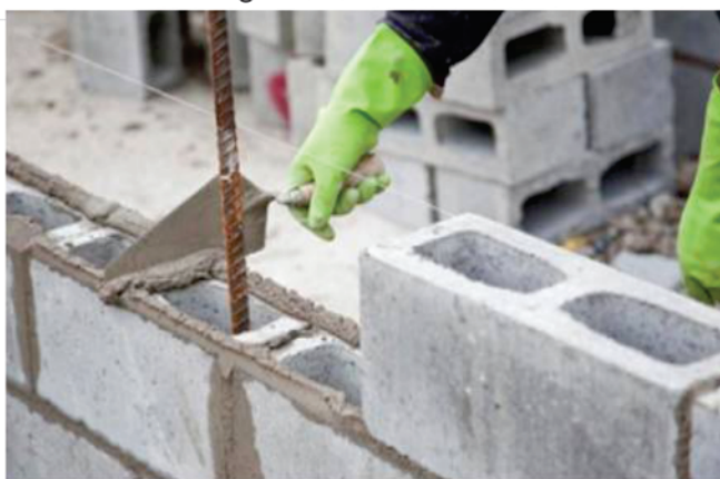
Argamassa na horizontal
