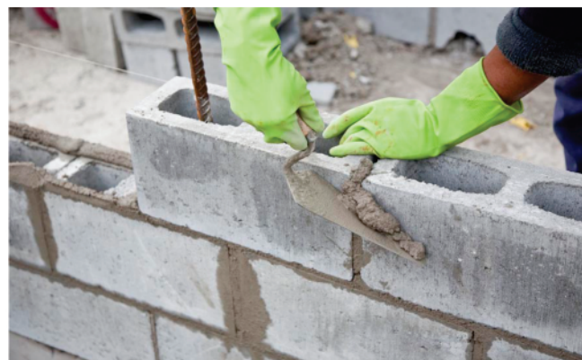
Limpeza do bloco após assentamento
