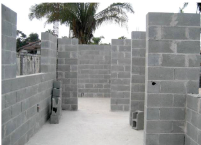
Alvenaria em bloco de concreto
